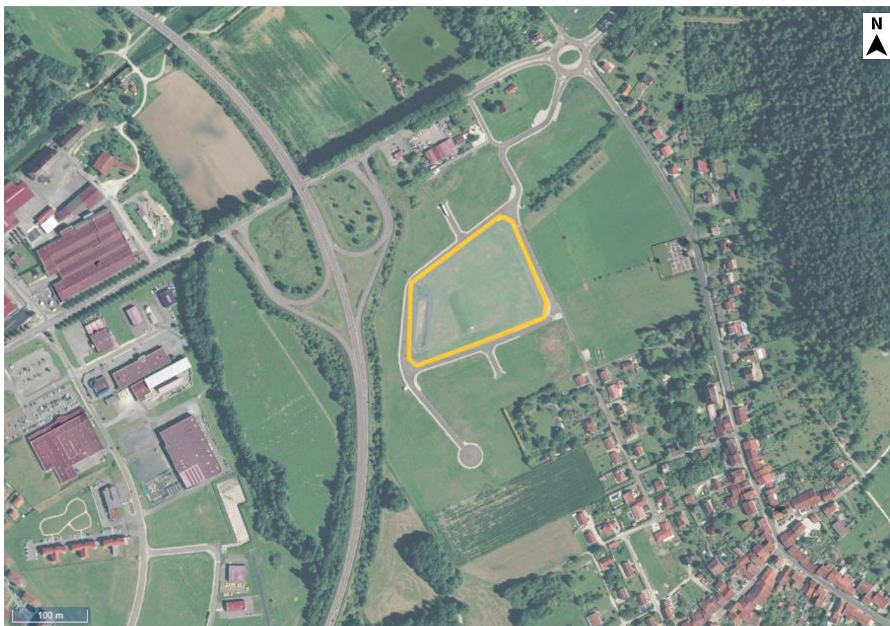
Localisation du site dans son environnement
